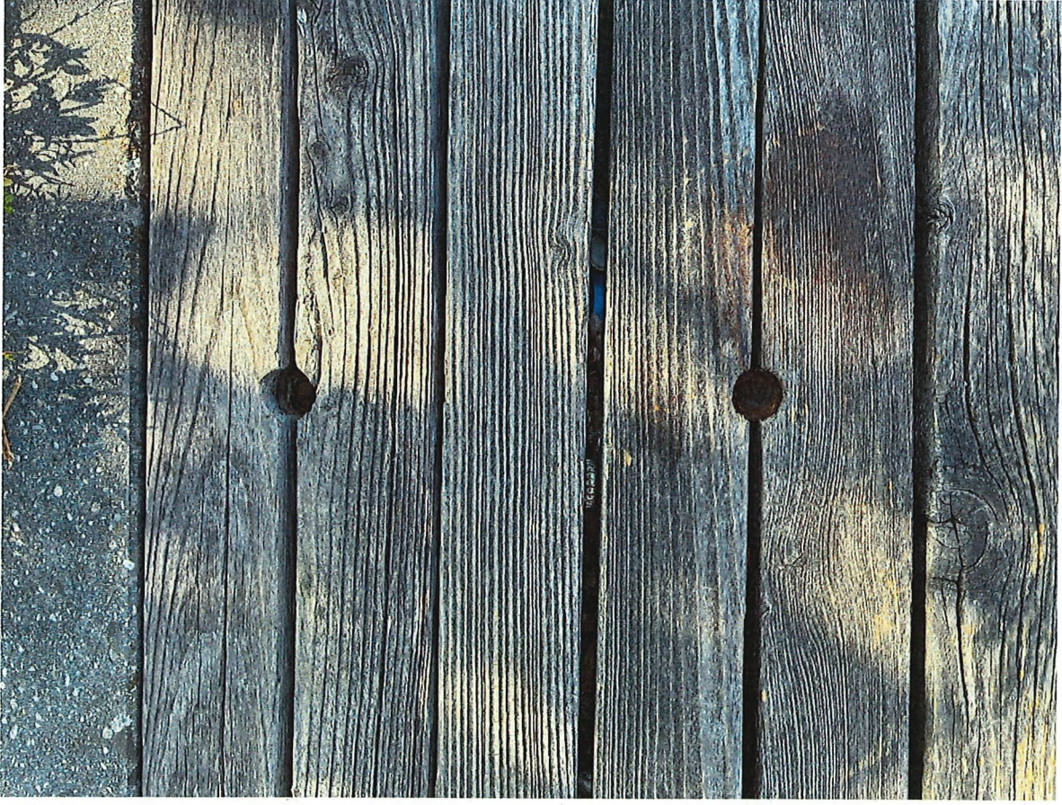
Foto Befestigung Sitzbankkonstruktion
