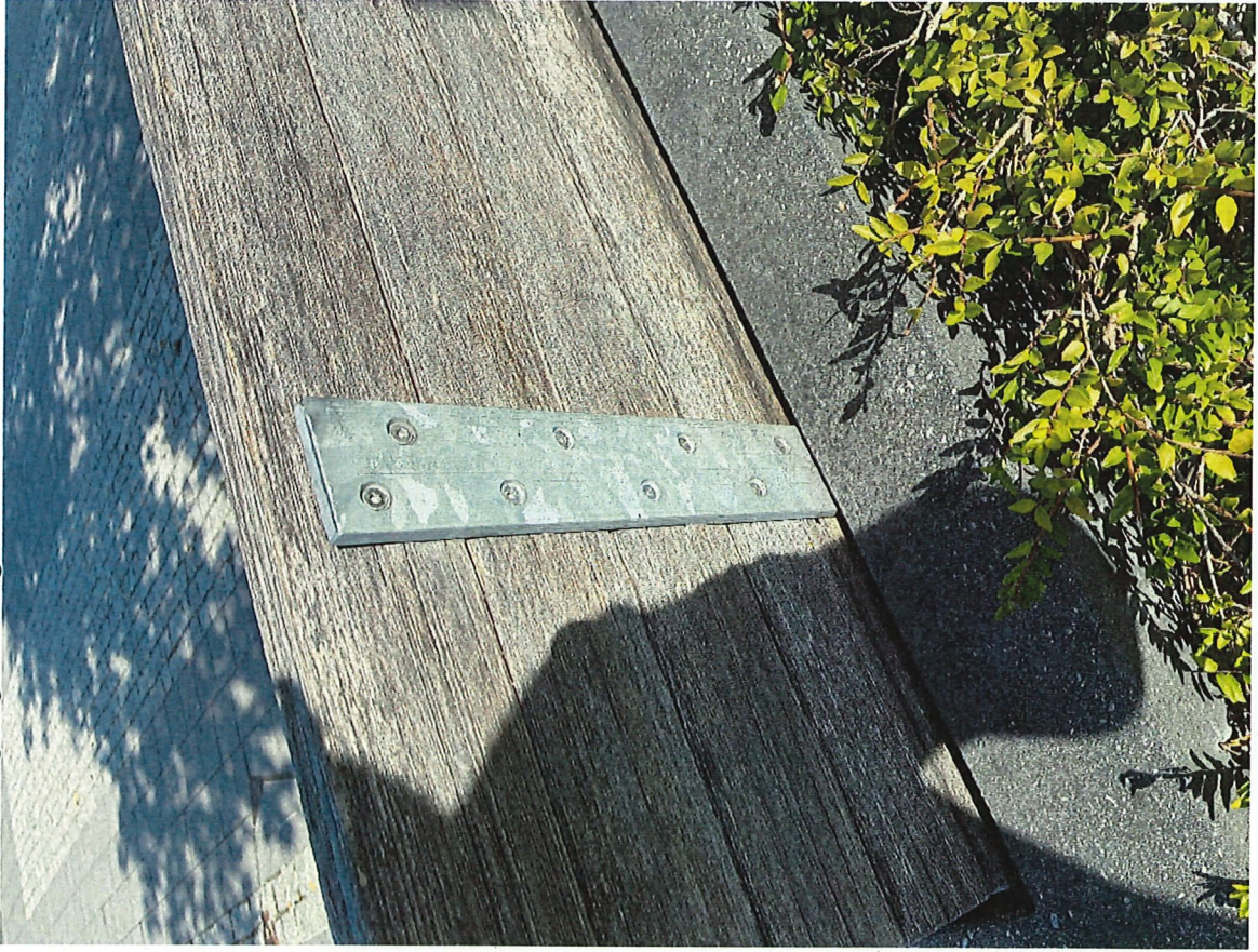
Foto Befestigung Lattung
